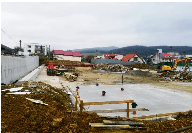
Stará a nevyhovujúca športová hala bola zrovnaná so zemou, na jej mieste začala vyrastať nová
