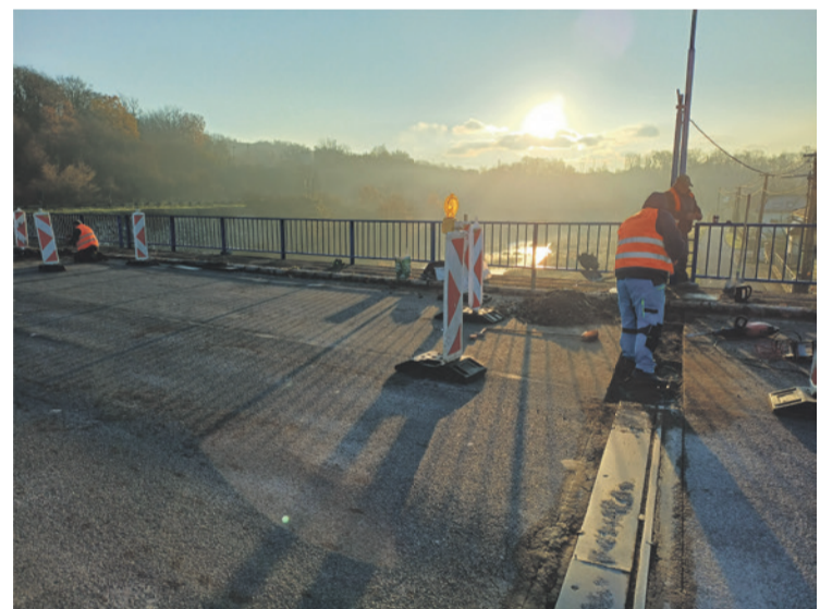
Na moste boli opravené dilatácie
