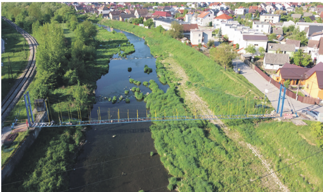
Na lávke sa počas rekonštrukcie menili náter, podlaha i pletivo
